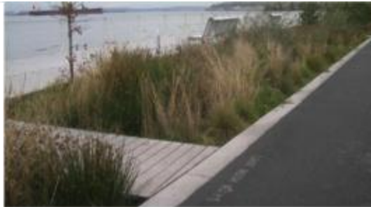
Area di ritenzione vegetata, porto di Seattle, WA, USA
