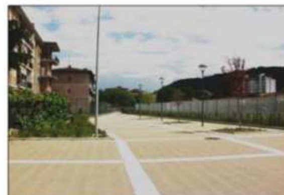
FOTO 2: Il collegamento con l'edilizia di Via Valpurga
