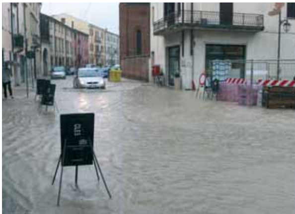
Prima dell'intervento, precipitazioni abbondanti causavano spesso l'allagamento di piazza XX Settembre e via Silvestri.
