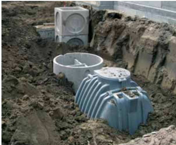
La vasca di accumulo d'acqua in Pead è il cuore del sistema di irrigazione. In calcestruzzo, i pozzetti a forma cubica di collegamento tra invaso e sistema irriguo e di troppo pieno del medesimo, e il pozzetto disoleatore di forma cilindrica.
