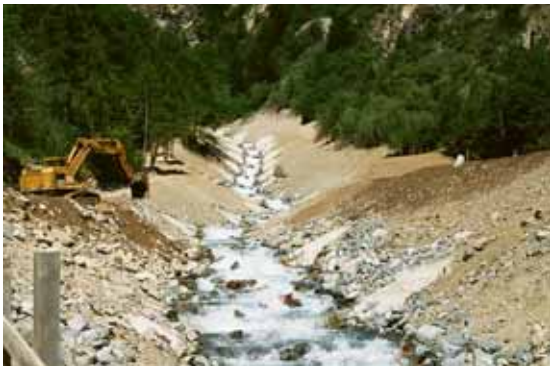
Il rio Melz a Clusio/Alto Adige immediatamente dopo le opere di sistemazione tramite briglie di consolidamento.
