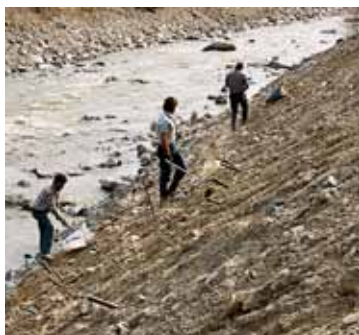
▮ Piantagione della parte inferiore di una sponda di talee di salici elastici.
