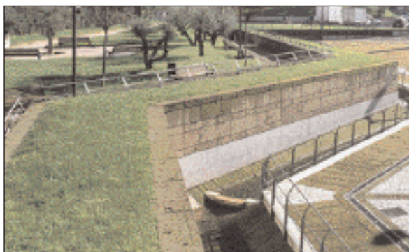
Sistemazione di percorsi e creazione di luoghi di aggregazione nel riqualificato "Parco Guido Rossa".
