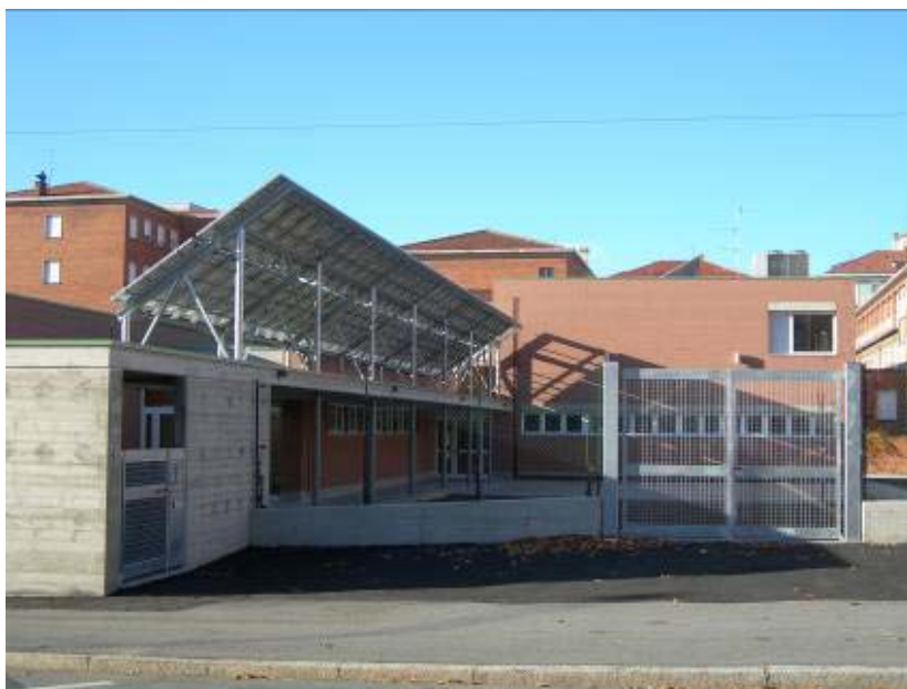
Istallazione di un impianto fotovoltaico in un asilo
