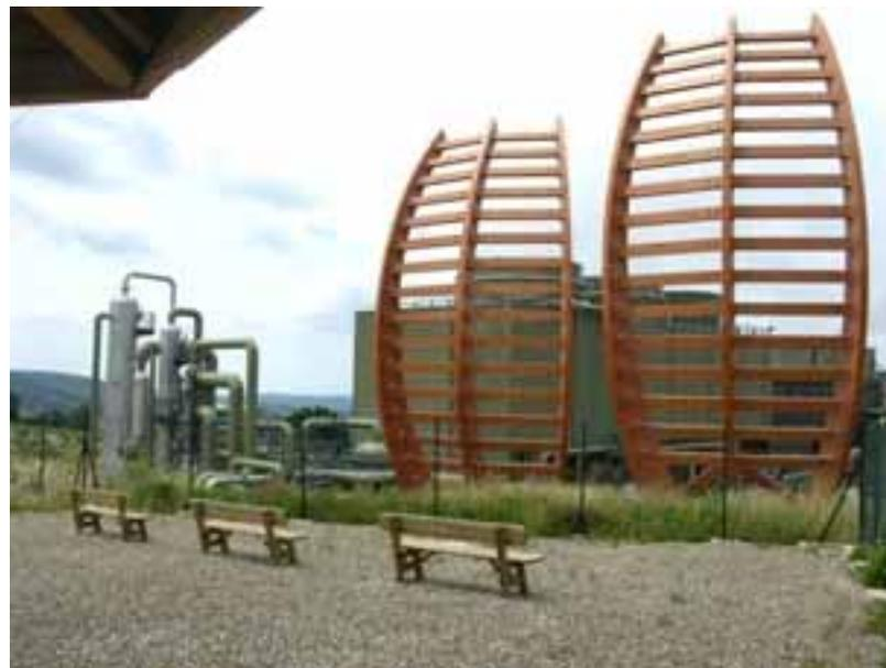
**Installazione di impianti di abbattimento mercurio e idrogeno solforato nelle centrali geotermiche**
