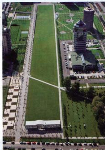
Brescia - parco tarellò: realizzazione del nuovo parco.
